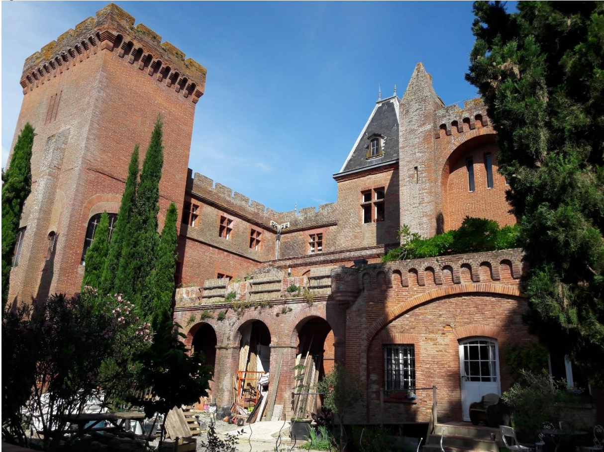
Figure 10 : Aile est du château, encore en travaux
