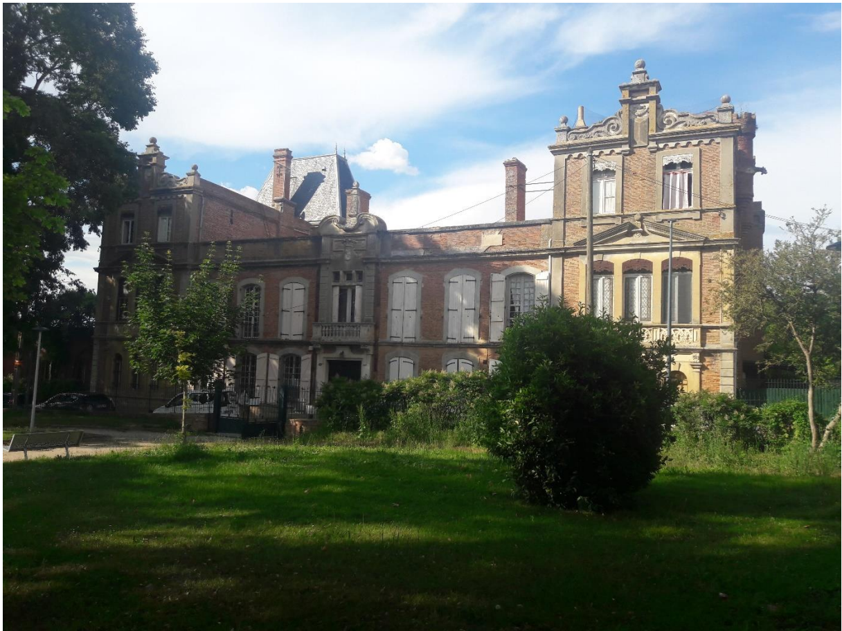
Figure 9 : Façade sud du château depuis le parc de la Marquise
